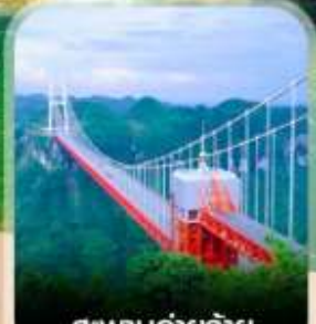
สะพานอ้ายจ้าย
